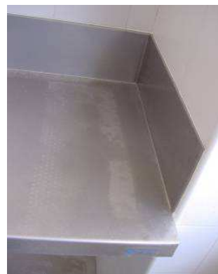
Detalle del acabado de los laterales, adaptándonos a la ubicación en obra.
